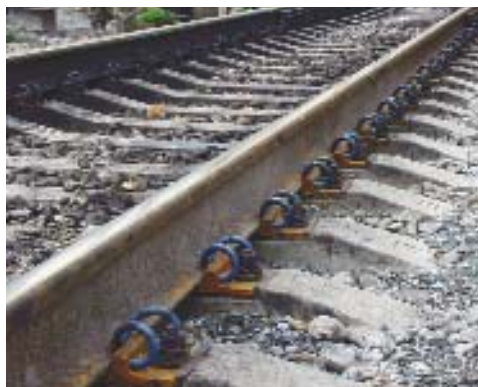
Новые рельсовые скрепления
