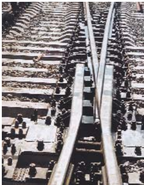
Крестовина с подвижным сердечником стрелочного перевода типа Р65 марки 1/11
