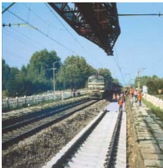
Укладка звеньевое пути на железобетонных шпалах
