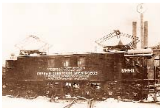
Первый отечественный электровоз постоянного тока ВЛ19
